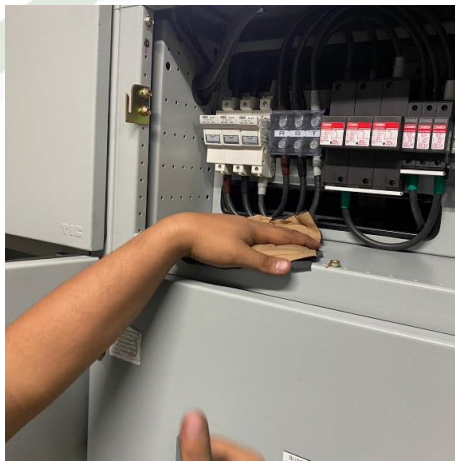
ทำความสะอาดตู้ควบคุมไฟฟ้าและอุปกรณ์ไฟฟ้า
