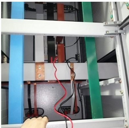
ทดสอบค่าความเป็นฉนวนระหว่างเฟส
