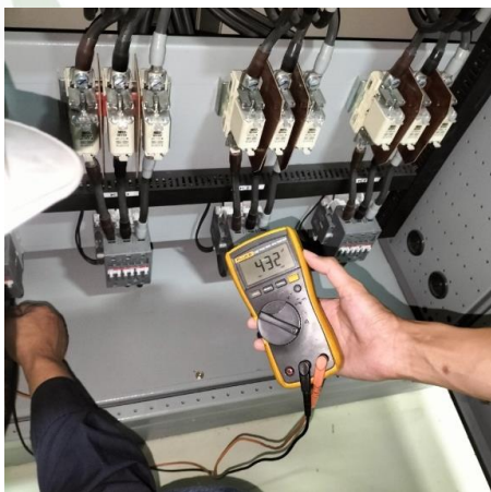
ทดสอบค่าความเก็บประจุของคาปาซิเตอร์
