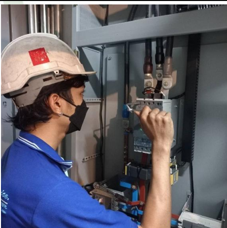
ทำความสะอาดวงจรหม้อตัดควบคุมไฟฟ้าและอุปกรณ์ไฟฟ้า
