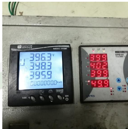
ทดสอบแรงดันอุปกรณ์ป้องกันไฟฟ้า
