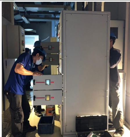
ทำความสะอาดตู้ควบคุมไฟฟ้าและอุปกรณ์ไฟฟ้า
