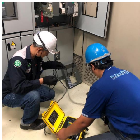
ทดสอบค่าความต้านทานหน้าสัมผัสตัวนำไฟฟ้า
