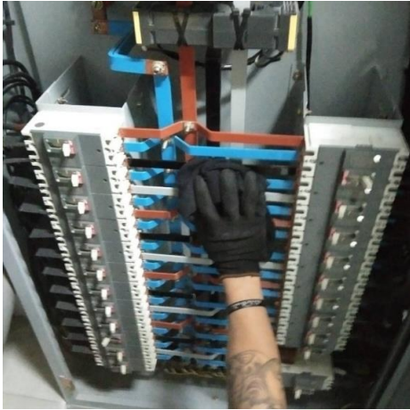
ทำความสะอาดวงจรน็อตตู้ควบคุมไฟฟ้าและอุปกรณ์ไฟฟ้า
